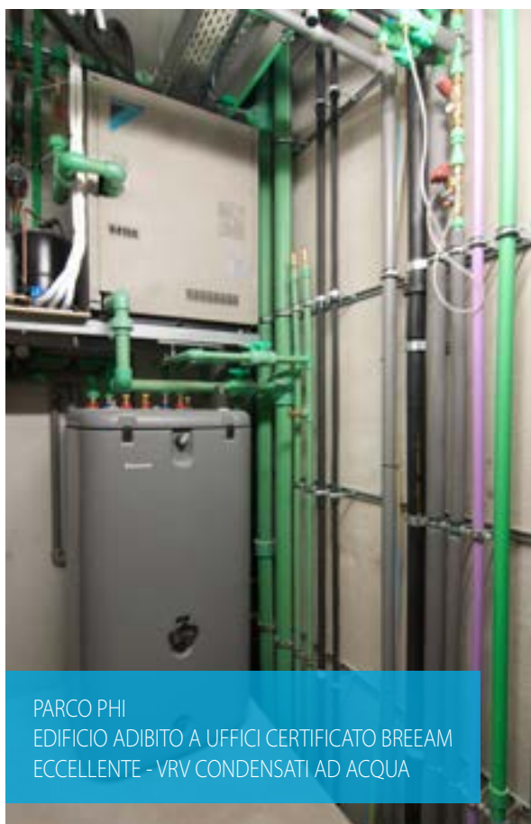
EIFFAGE ENERGIE ED EIFFAGE ENERGIE THERMIE EDIFICIO USO UFFICIO POMPA DI CALORE VRV IV CON RISCALDAMENTO CONTINUO
