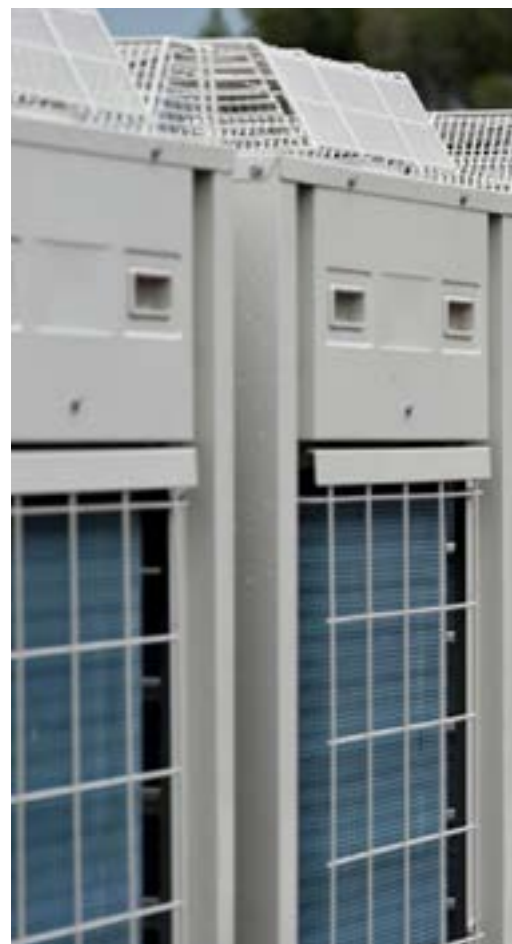
EIFFAGE ENERGIE ED EIFFAGE ENERGIE THERMIE EDIFICIO USO UFFICIO POMPA DI CALORE VRV IV CON RISCALDAMENTO CONTINUO
